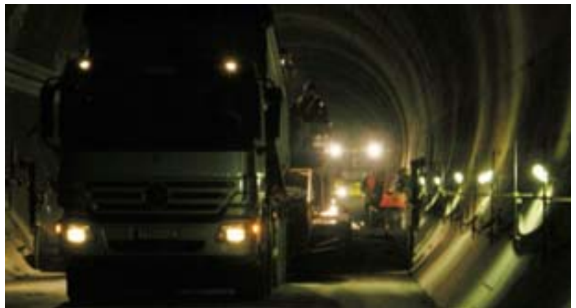
Temperaturabgesenkte Walzasphalt im Schlüchterner Tunnel
