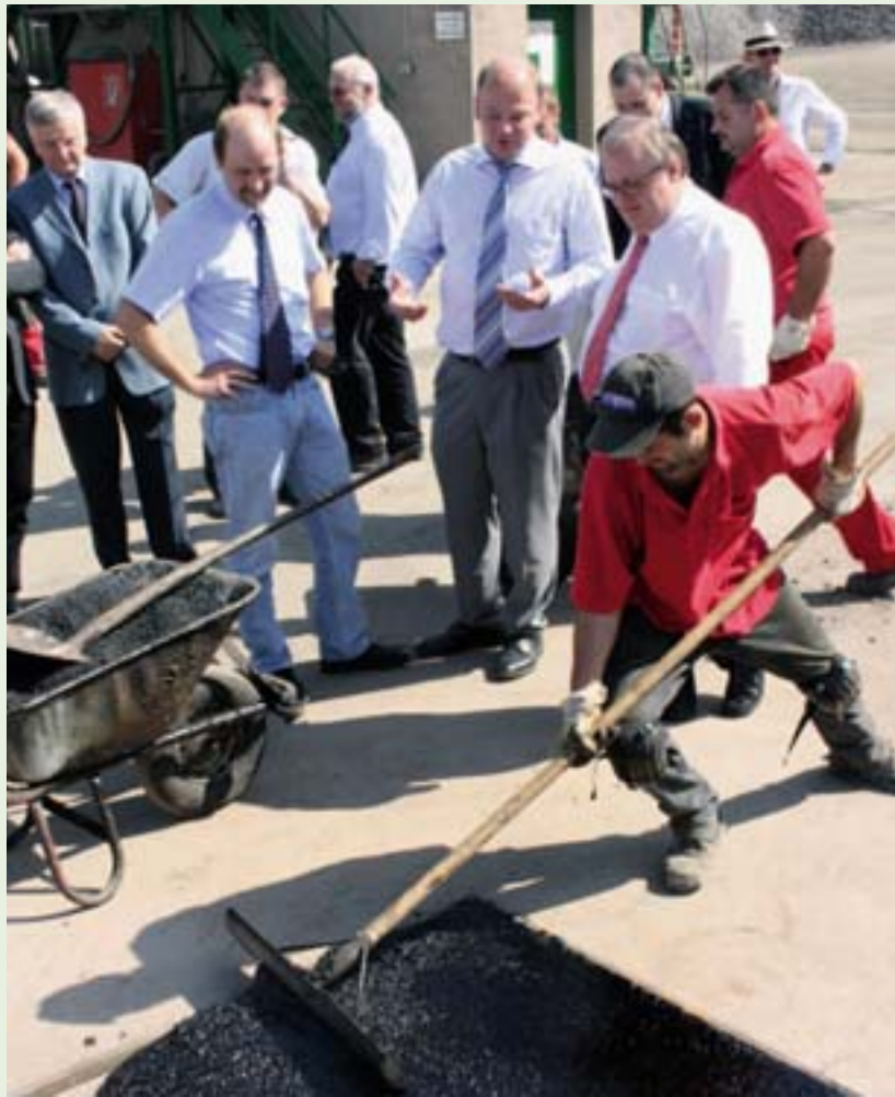
Herr Ottmar Schütz erläutert Minister Jürgen Banzer den Gussasphalteinbau
