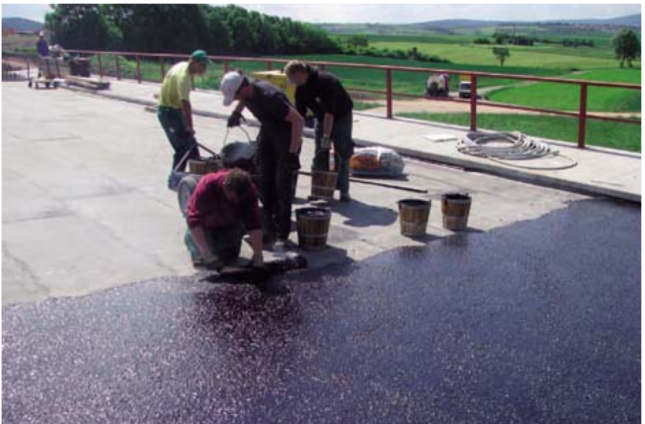
Glätten von Gussasphalt auf einer Brücke
