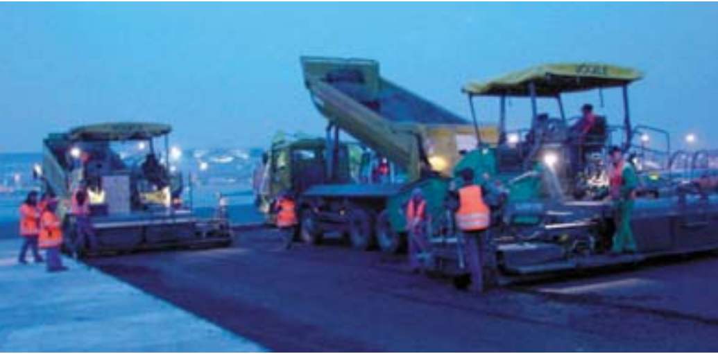
Frankfurter Landebahn wird bei abgesenkter Temperatur saniert
