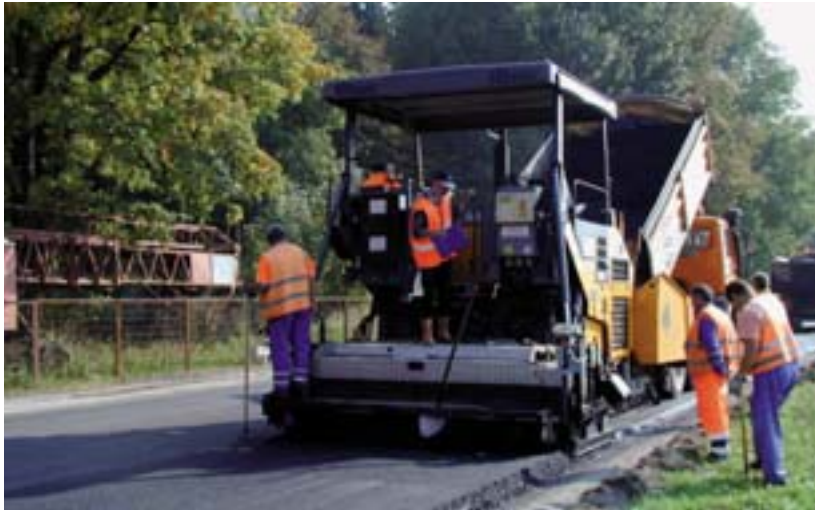
Asphalteinbau bei abgesenkten Temperaturen in Slowenien
