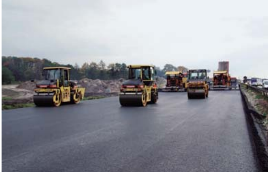
Einbau von Walzasphalt
