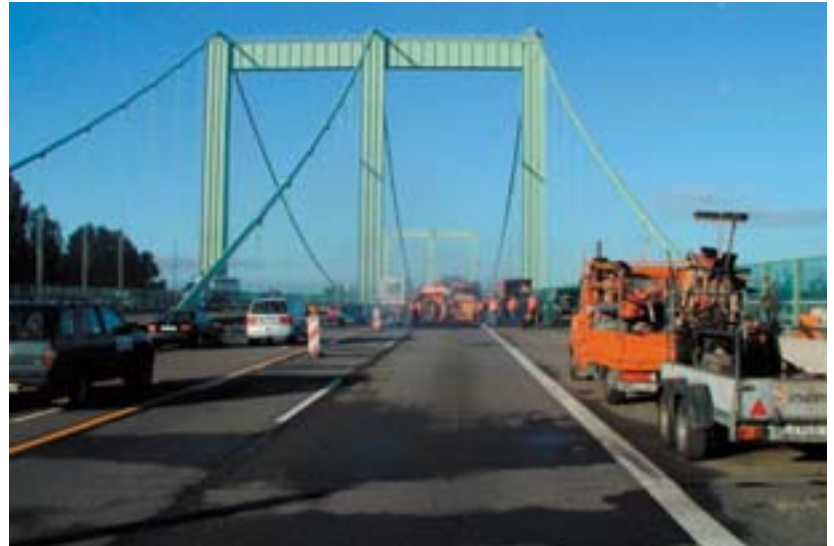
Brückenbeschichtungen werden durch abgesenkte Temperatur geschont
