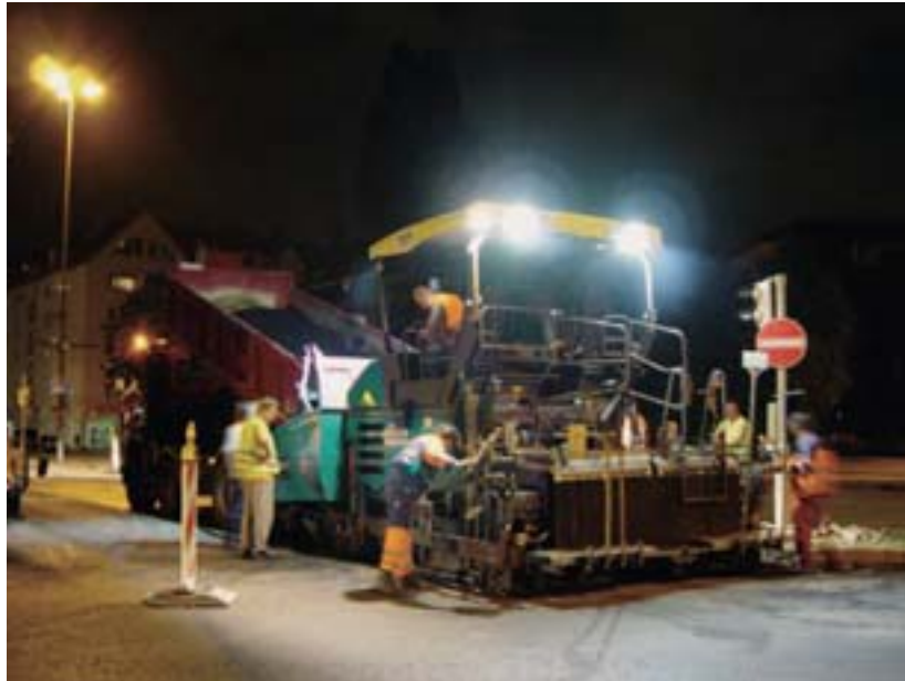
Temperaturabgesenkter Walzasphalt ermöglicht frühe Verkehrsfreigabe bei Münchner Nachtbaustellen
