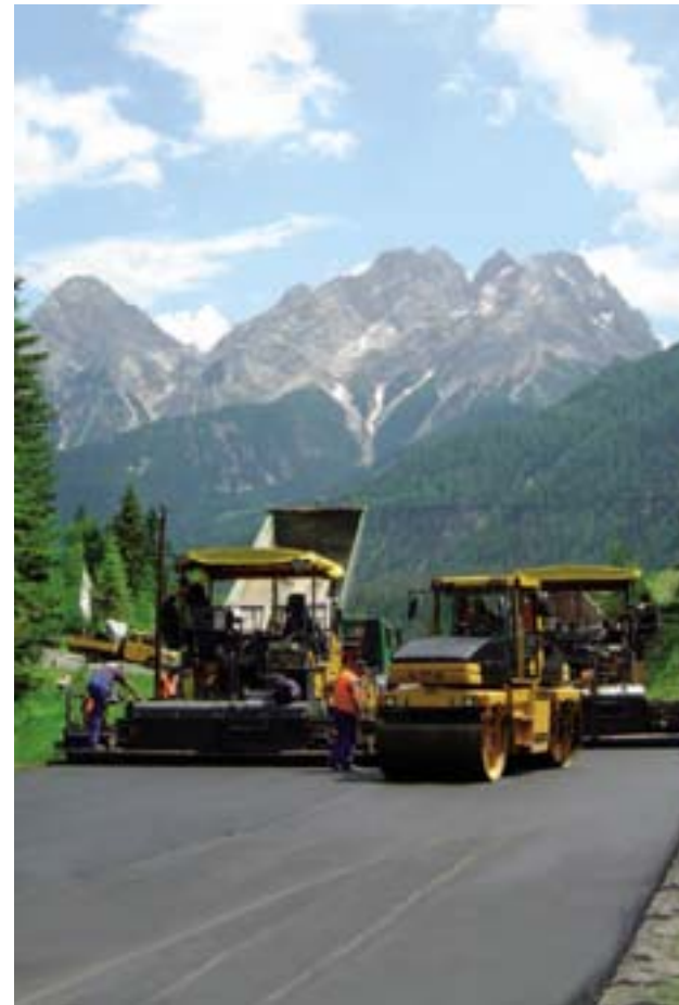
Einbau bei abgesenkten Temperaturen am Fernpass
