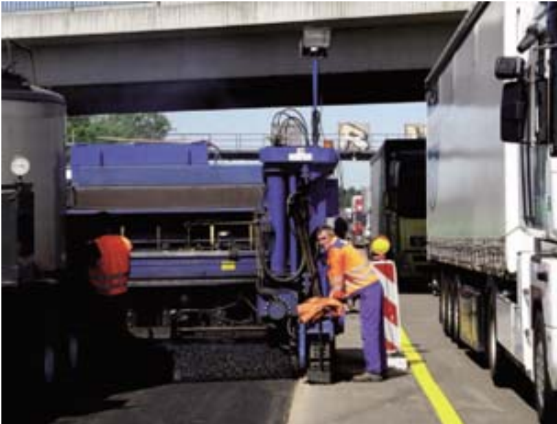
Temperaturabgesenkter Gussasphalteinbau bei Obertshausen
