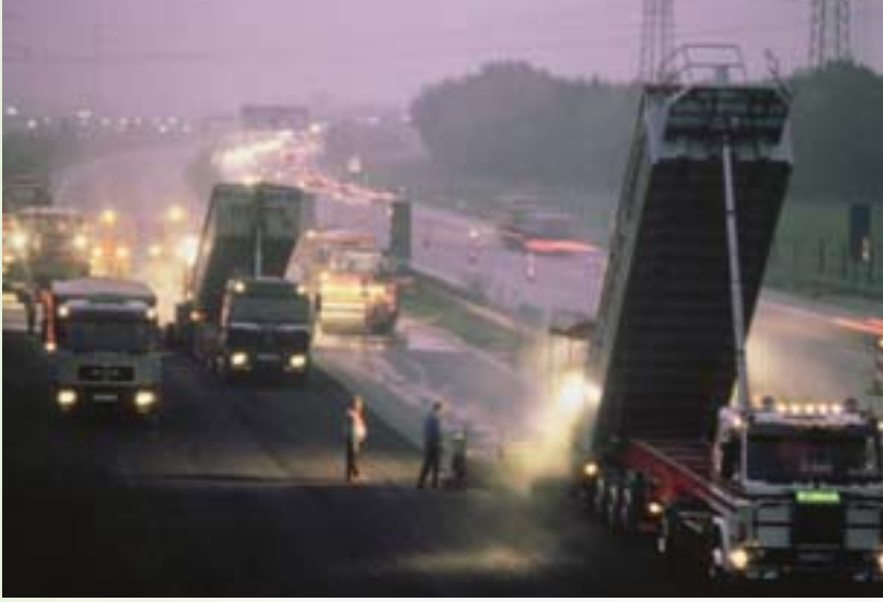
Einbau von Walzasphalt
