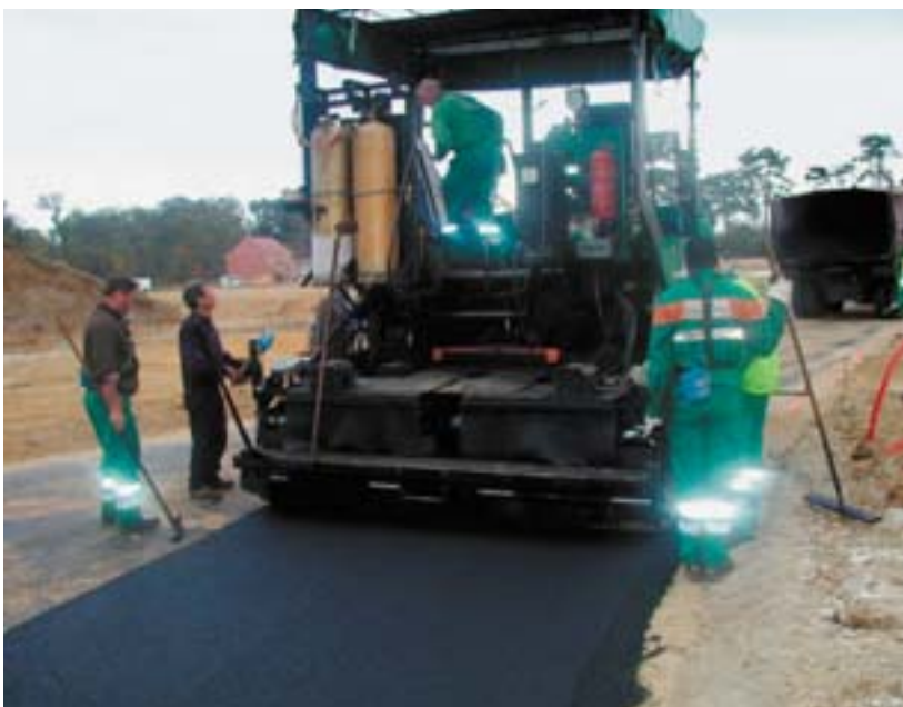
Einbau bei abgesenkten Temperaturen auch in Frankreich
