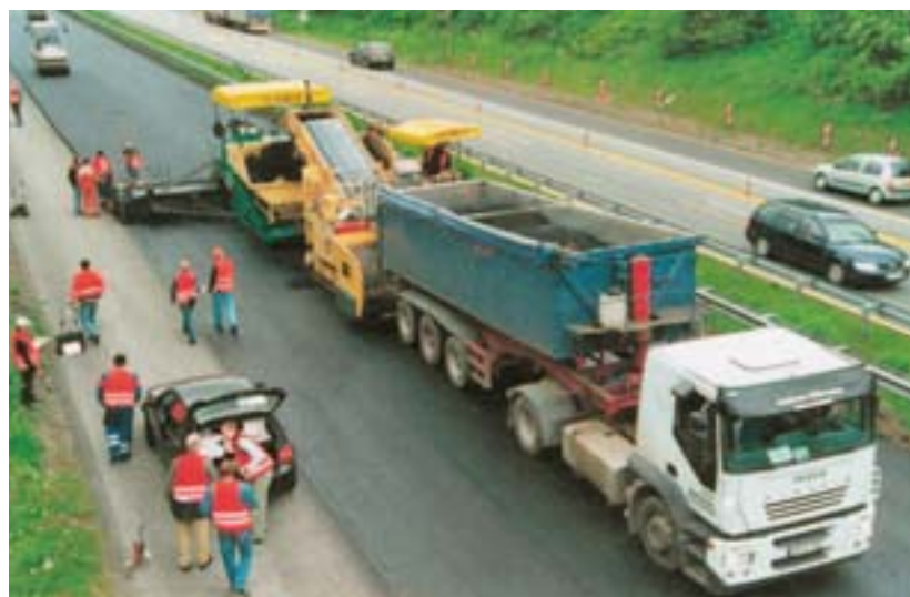
Einbau mit abgesenkten Temperaturen auf der A 7
